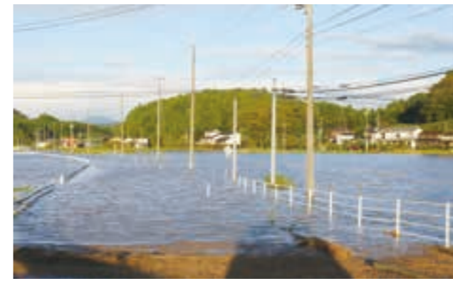
令和元年台風19号により冠水した逢隈田沢付近（主要地方道巨理村田線）
