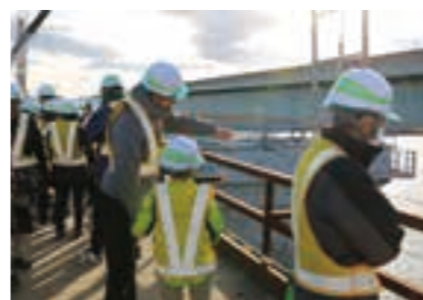
仮設橋の上から工事現場を見学する参加者たち
