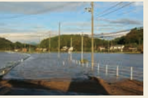
▲【10月13日】 台風19号により冠水した逢隈田沢付近（主要地方道巨理村田線）
