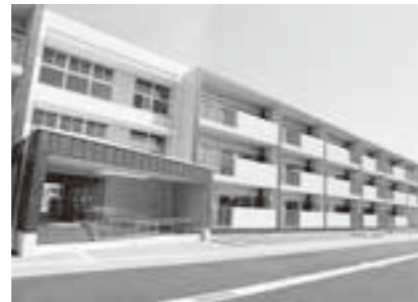
公営住宅（大谷地住宅）
