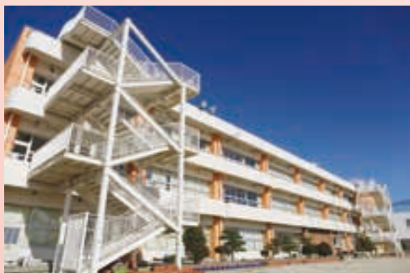
校舎南面に設置された避難用外階段
