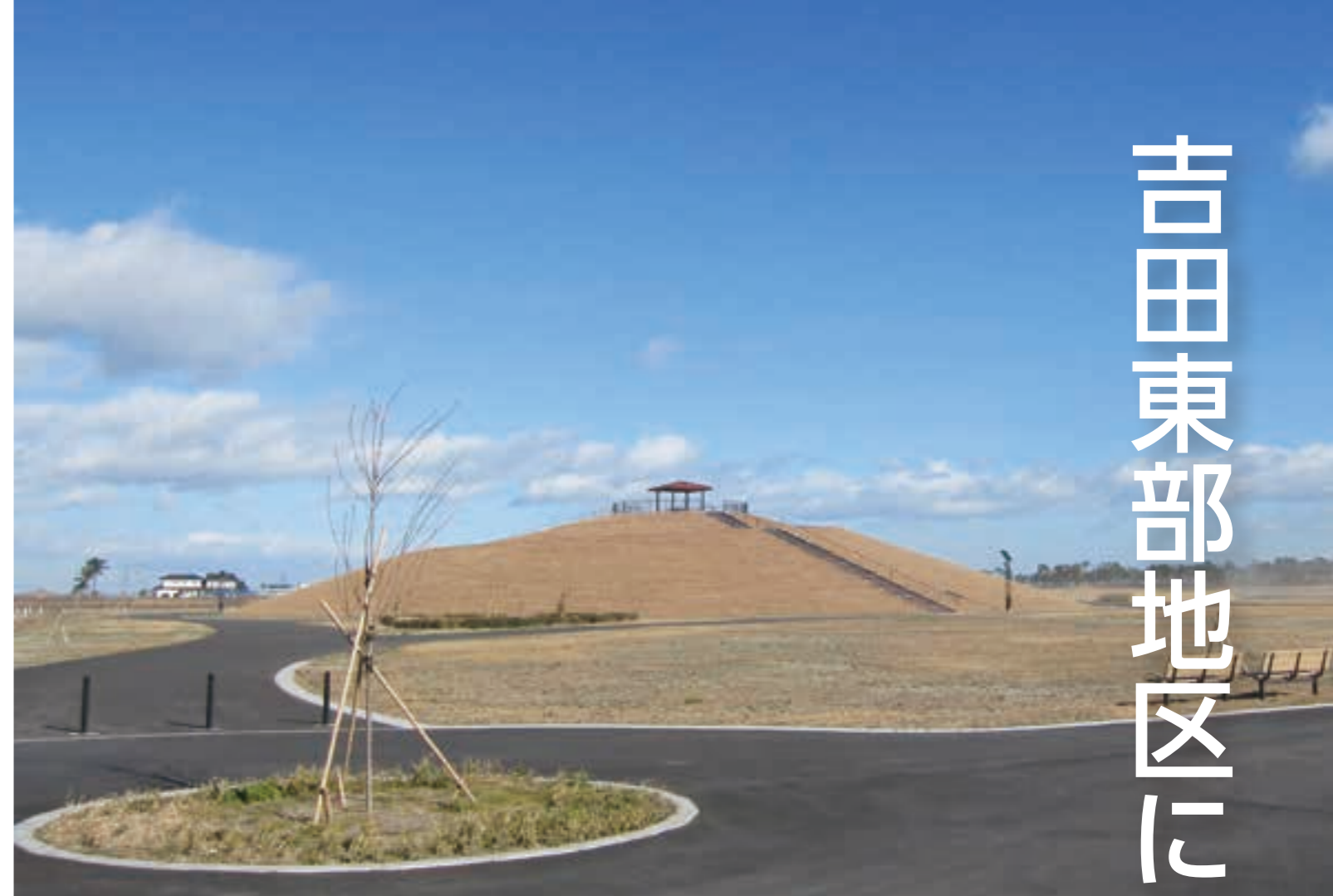
T.P.9メートルの避難丘が配された防災公園（大畑浜南防災公園）
