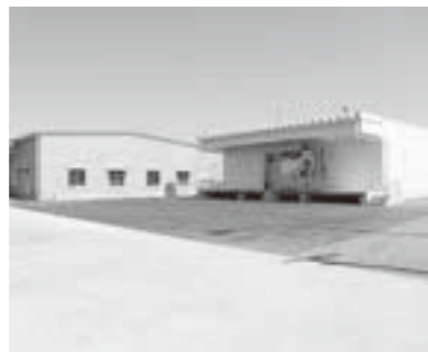
漁港前に整備された貯氷施設（手前）と荷捌き場
