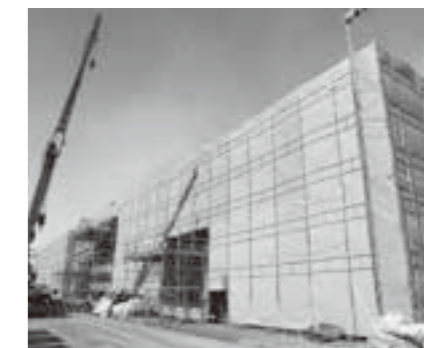
建設中の災害公営住宅 吉田大谷地（集合）
