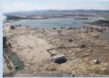
東日本大震災発生「荒浜旧5丁目区周辺」 (平成23年3月11日)
