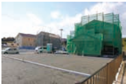
▲【3月5日】引き渡され、家屋の建築が進む防災集団移転先 吉田南河原団地
