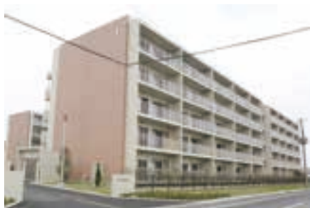
▲【8月18日】町内で初めて完成した災害公営住宅 西木倉(集合)
