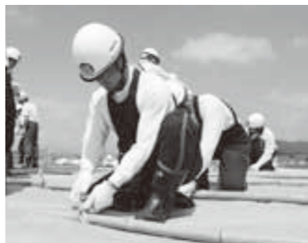
シート張り工法で手際良く竹を結び付ける消防団員
