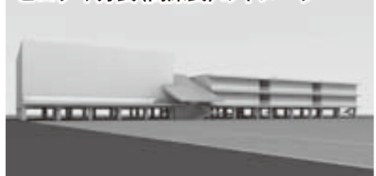
1階部分に壁が無く柱のみの建築構造です。2階からが教室などの空間となります。
