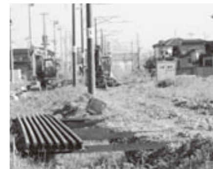
復旧工事が進む常磐線
