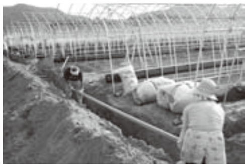
ハウスの整備に追われる生産者(小山地区)
