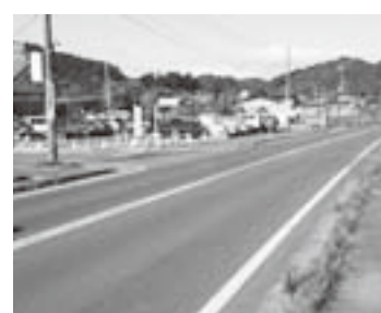
右折レーンが設置される国道6号(葬祭場入口)
