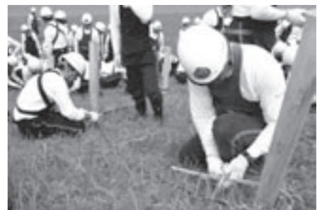
PHOTO 竹と縄を使って水防工法を実践する団員たち
