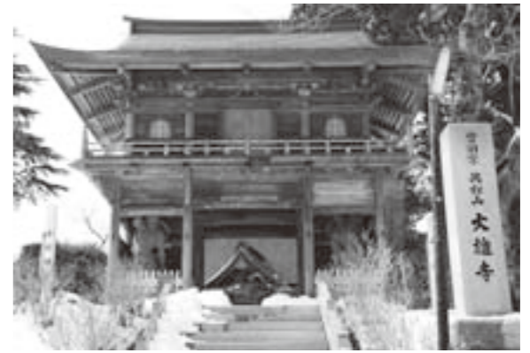
▲修復が完了した山門
