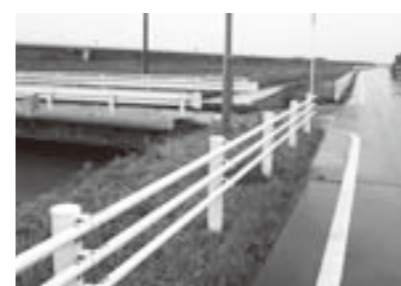
見通しの改善が望まれる青沼橋と改修されたガードパイプ
