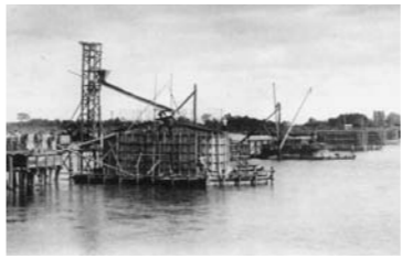
阿武隈橋の架橋作業(昭和5年ごろ)
