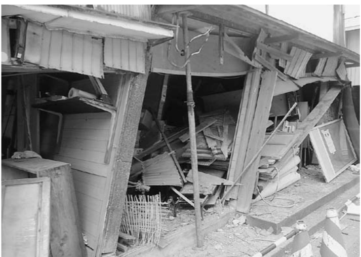
平成19年の新潟県中越地震で倒壊した家屋
