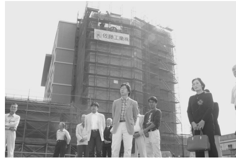
建設中の「わたり温泉鳥の海」を視察する検討委員
