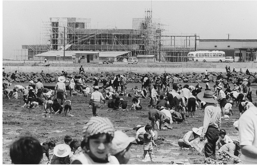
潮干狩り場から見る巨理町国民保養センター「鳥の海荘」の建設風景 (昭和44年4月頃)
