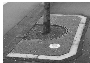
荒浜築港線歩道の植樹柵に取り付けられています
