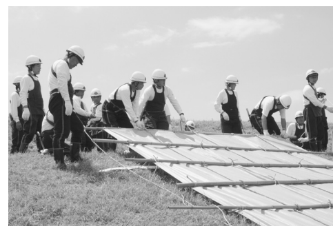
手際よく作業を進める参加者(シート張り工法)
