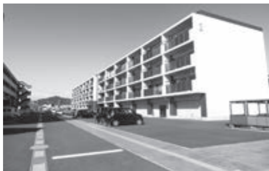
入居から7年が経過、下茨田南災害公営住宅
