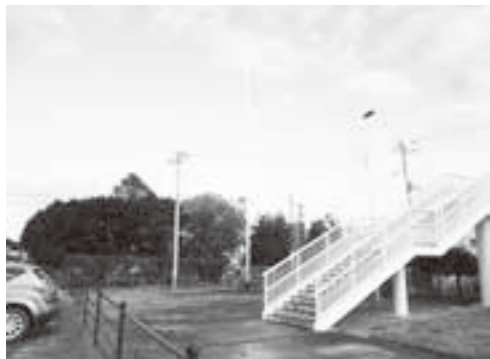
巨理小学校西側に整備される防災無線
