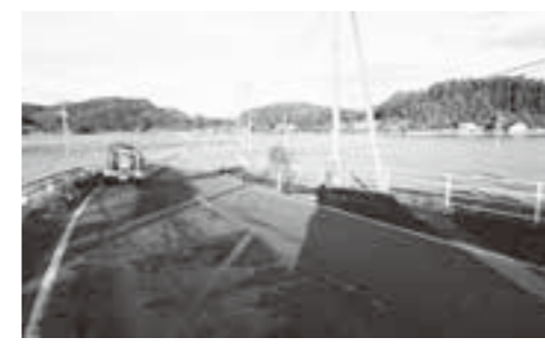
台風19号による道路冠水 逢隈 田沢地区
