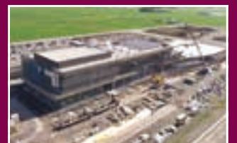
完成間近 新庁舎
