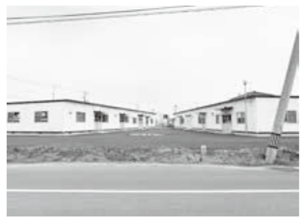
今後利活用が期待される仮設倉庫
