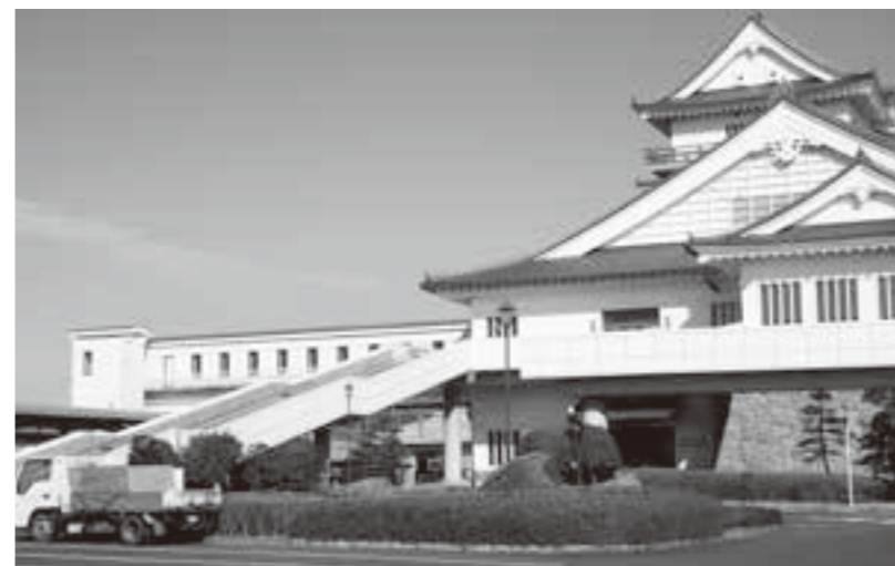
巨理山元商工会が入居している悠里館
