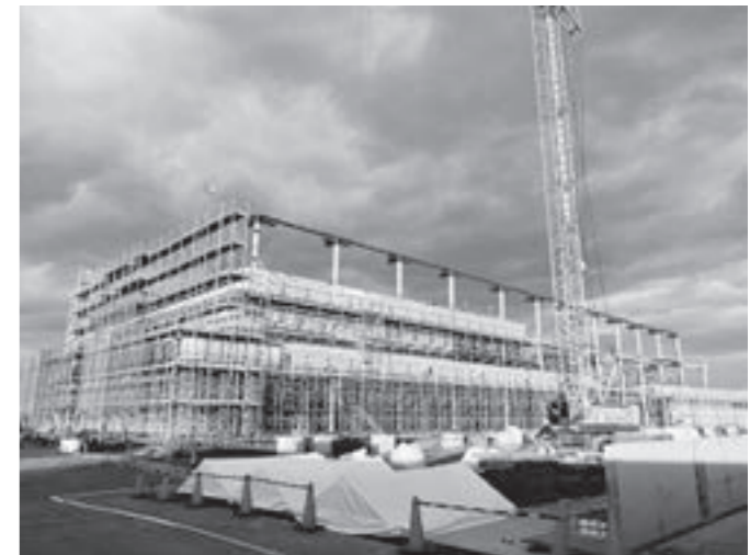
建設中の新庁舎
