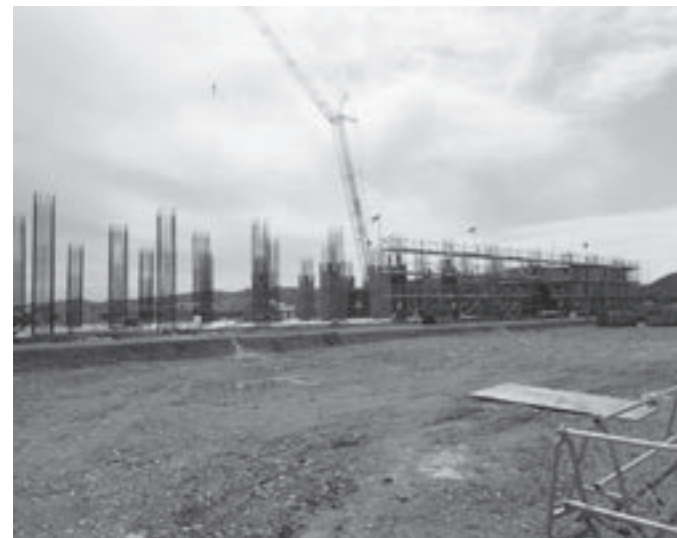
進む庁舎建設 9月18日撮影
