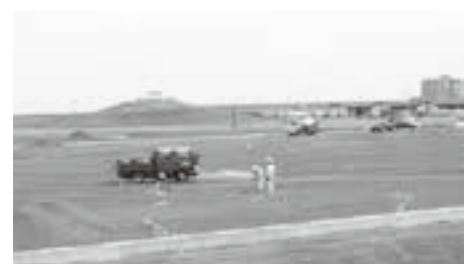
着々と進む陸上競技場等整備
