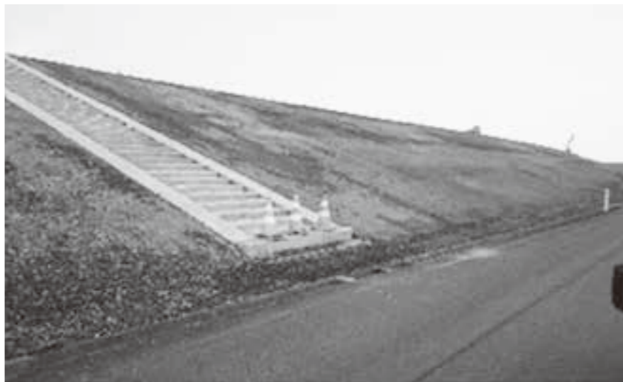
工事中の阿武隈川堤防(今泉区)
