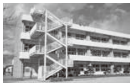
外階段から入室可能な荒浜小学校
