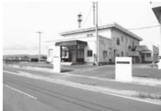
早期復旧が望まれる公共施設（荒浜支所）
