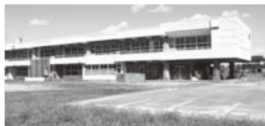
被災した長瀬小学校
