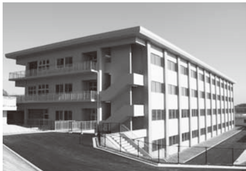
新築した宮城病院病棟
