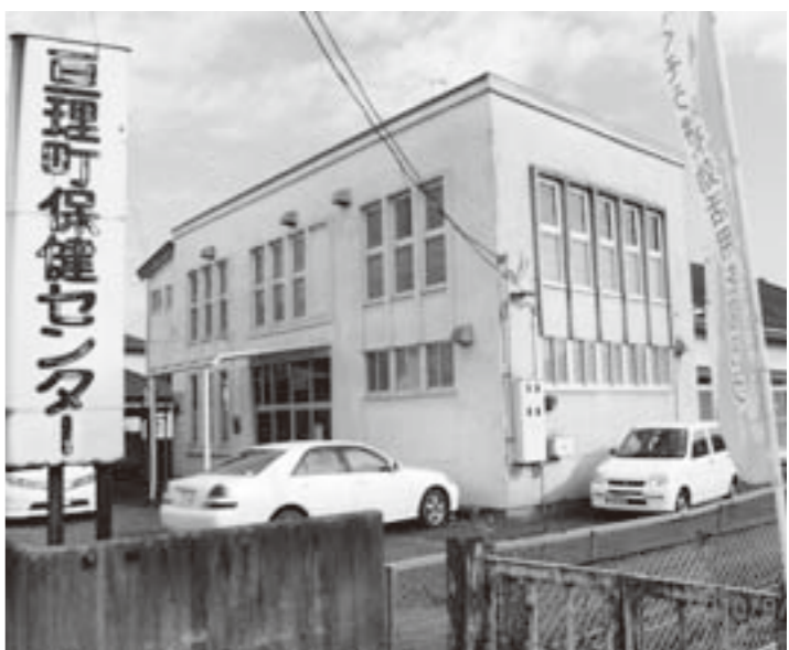
昭和28年に建設された保健センター
