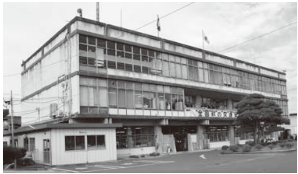
昭和38年に建設された現在の役場庁舎
