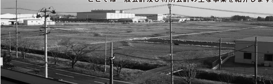
新たな企業が進出する建設予定地（逢隈高屋西部地区）
