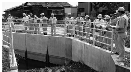
鹿島川雨水幹線工事
