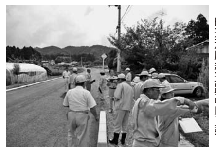
町道河原線道路改良工事
