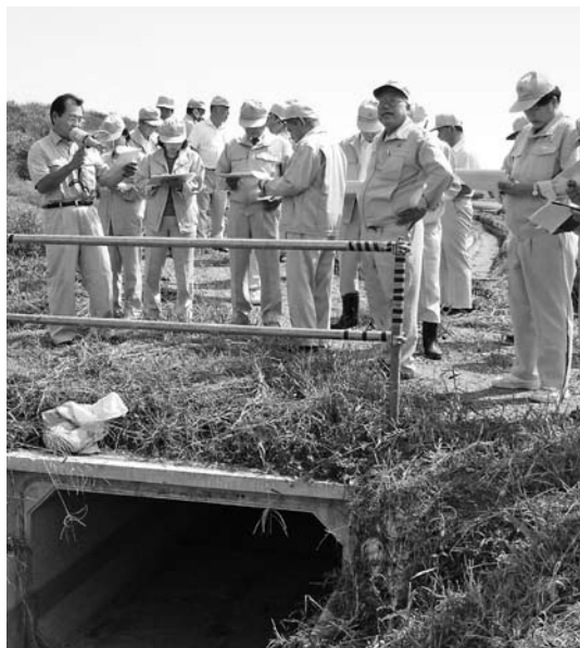
今泉農業用排水路改修工事
