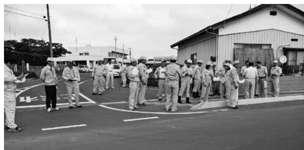
町道浜道線道路改修工事
