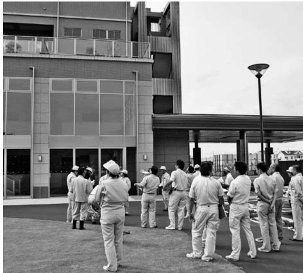
わたり温泉鳥の海建設工事
