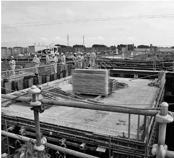
鍋倉川排水路改修工事現場
