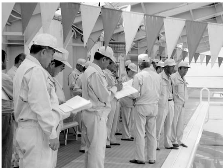
現地調査 (B&G海洋センタープール改修工事)
