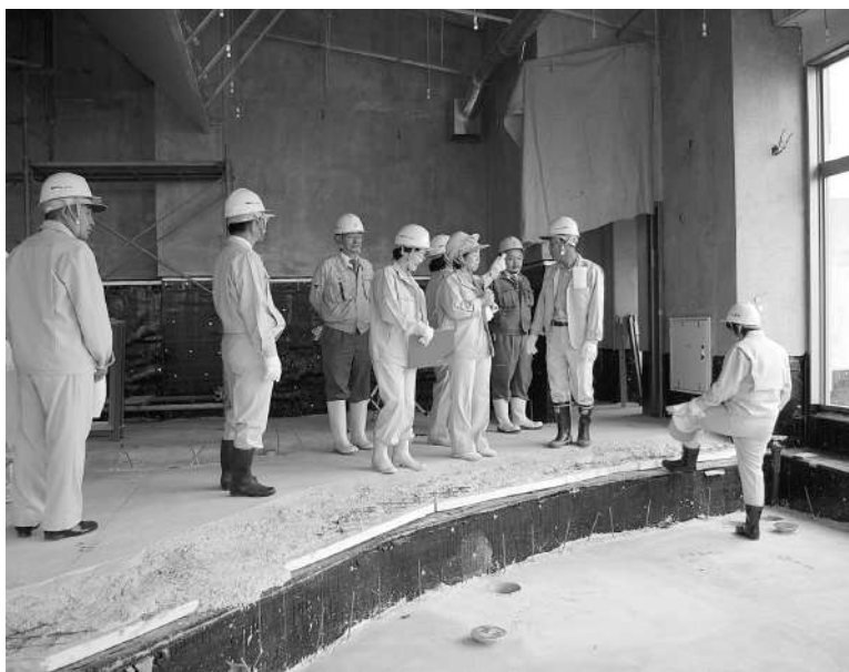
現地調査 (わたり温泉鳥の海建設工事)
