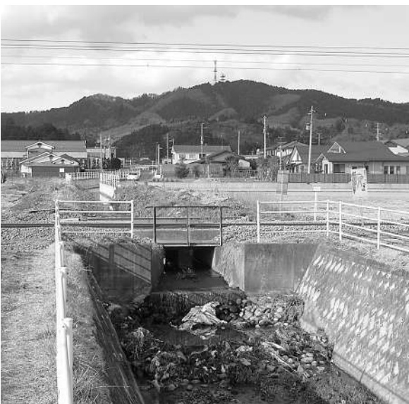
鍋倉川排水路とJR線路との交差部
