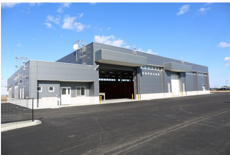
防災拠点として物流機能の軸となることが期待される
