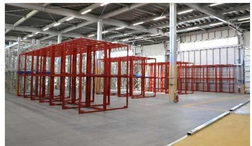
東日本大震災時の経験を踏まえ 備蓄に加えて物資の受入・仕分けを 十分に行えるスペースを有する
