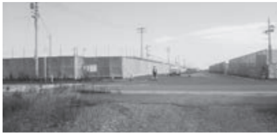
解体が進む公共ゾーン仮設住宅
