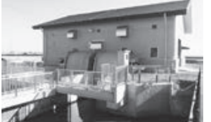
修繕完了した排水機場
