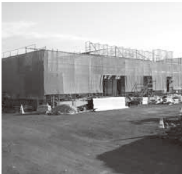
復旧工事が進む荒浜保育所
