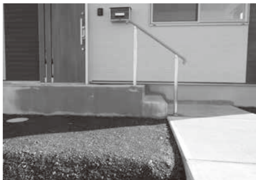
玄関の手すり（上浜街道戸建住宅）
